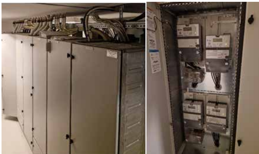
Bilde 6 Hovedtavler og sikringskap. Nytt og oppgradert.
