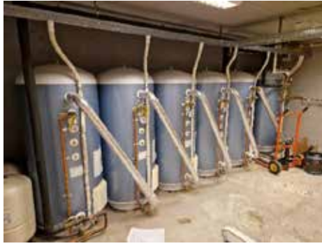
Bilde 4 – Bilde fra teknisk rom
